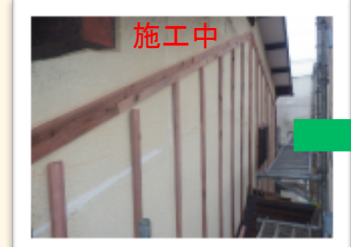
既存の壁にサイディングを張るための下地をします。
